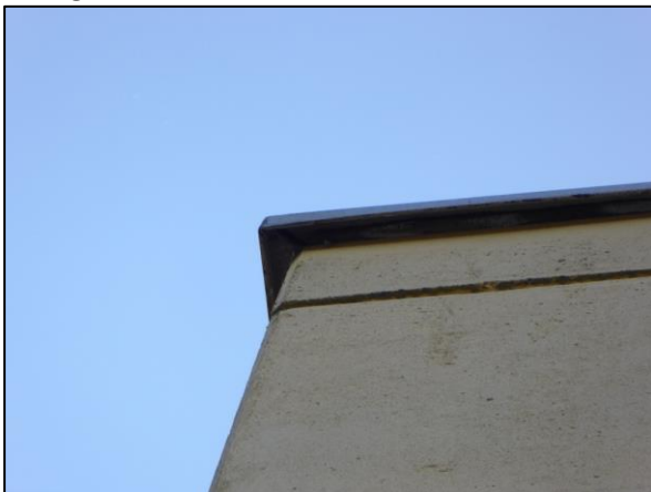
Bild 05: Detail des Dachüberstandes Gebäude A – möglicher Zugang für Fledermäuse / Vögel
