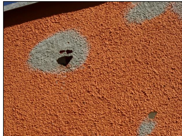
Bild 08: Detail der Südwestfassade Gebäude B – Hackspuren vmtl. vom Specht in der Wärmedämmung (ohne Nutzungsspuren von Fledermäusen)
