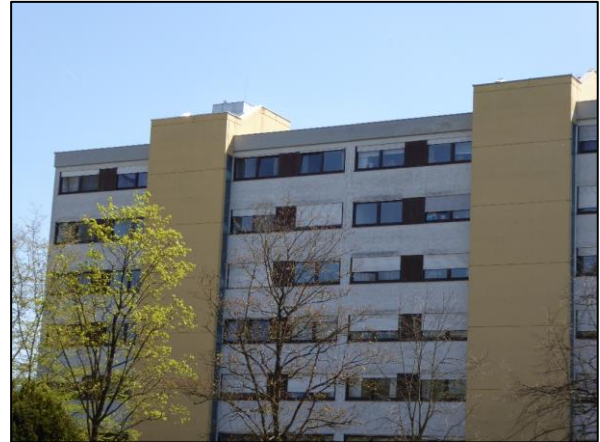
Bild 02: Blick auf das Haupthaus (Gebäude A) von Norden
