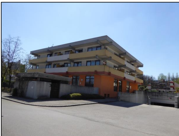
Bild 09: Gebäude D – nur geringes Quartierpotenzial
