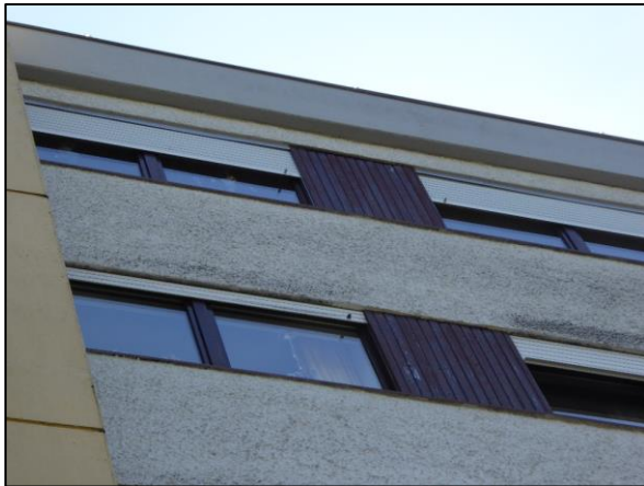
Bild 03: Detail der Nordfassade Gebäude A – potenzielle Spaltquartiere hinter Holzverkleidung bzw. über Rollläden
